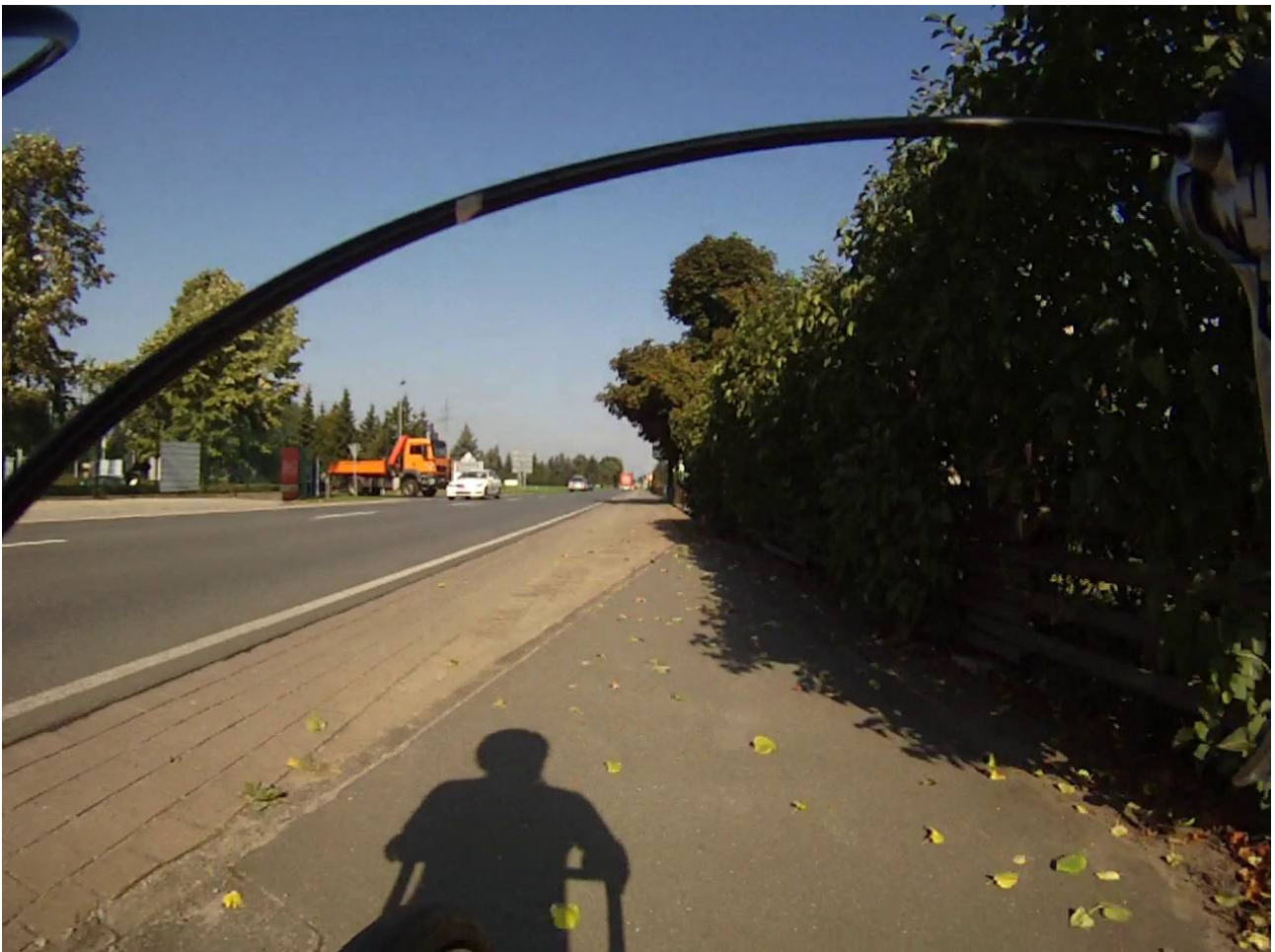
Bild 4: Leese, kurz vor der Einmündung Kampstraße: Der benutzungspflichtige Radweg verschwindet unter Zaun und Gebüsch um einem Verschwenkungsraum für links abbiegende LKW Platz zu machen.
