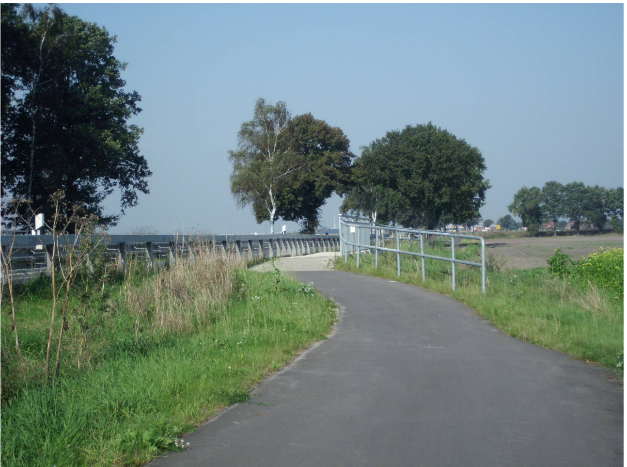
Bild 2: Während die Fahrbahn ohne echte Kurven auskommt, müssen die engen Kurven der Geh-/Radbahn mit Geländer gesichert werden.
